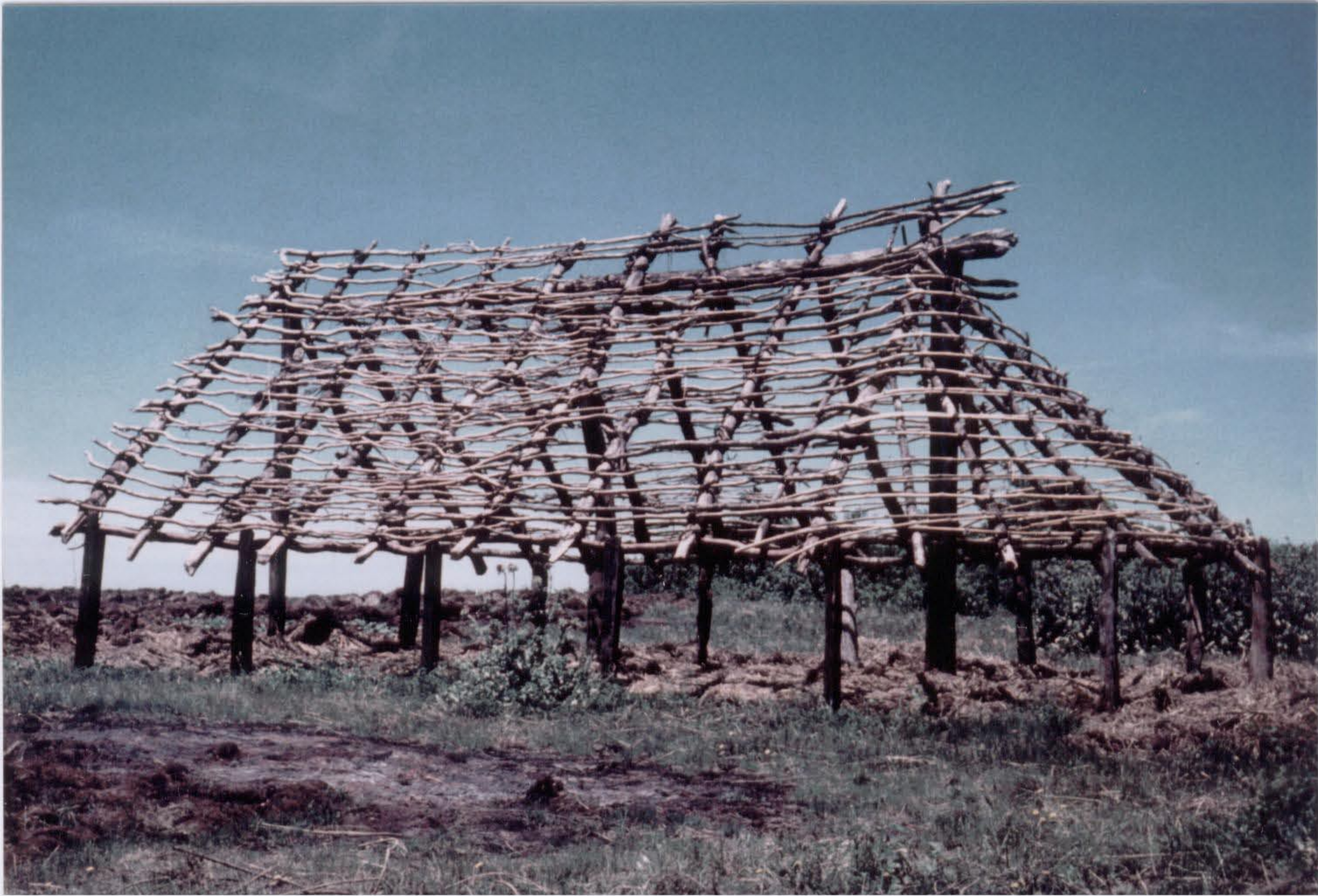
Gerüstbau einer RUKA, eines Mapuchen- Hauses. Die Bambusstäbe sind mit Lianen am Holzgerüst befestigt. Nägel finden keine Verwendung.
