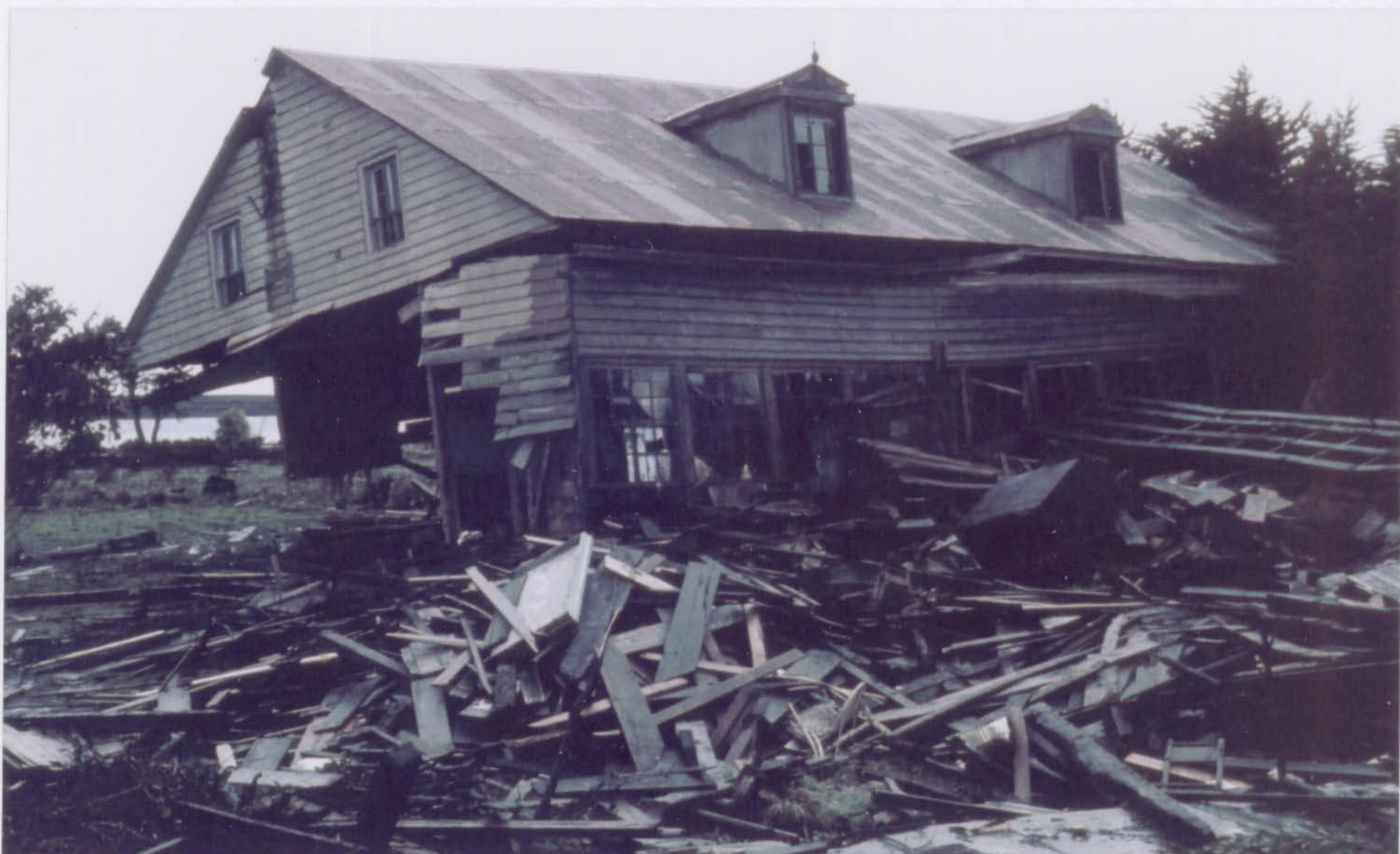
Meterhohe Wellen trugen dieses Haus in Puerto Saavedra fort
